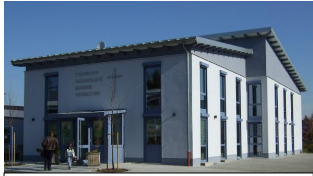
Gemeindehaus der EFG Wendelstein
